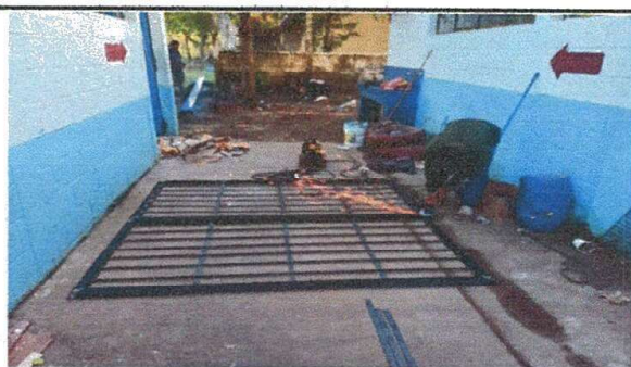
FOTO 5: MODULO I, Mantenimiento a balcones de metal.
