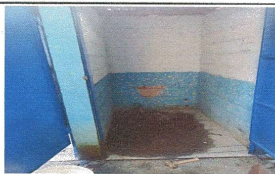
FOTO 4: MODULO III, SERVICIOS SANITARIOS Y SUS ACCESORIOS.
