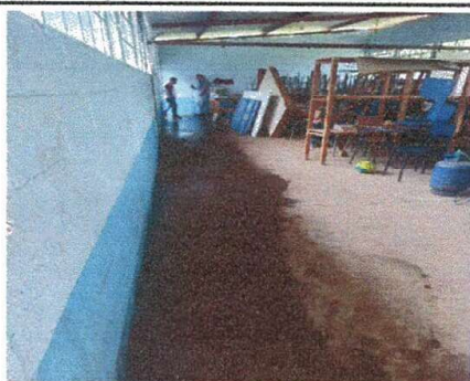
FOTO 1: MODULO I, Sustitución de torta de cemento por piso cerámico.
