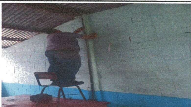
FOTO 3: MODULO II, Reparación del sistema Eléctrico.
