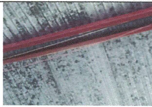
FOTO 2: MODULO II, Reparación del sistema eléctrico.
