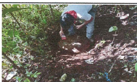
FOTO 6: MODULO IV, DRENAJE: Mantenimiento fosa septica.
