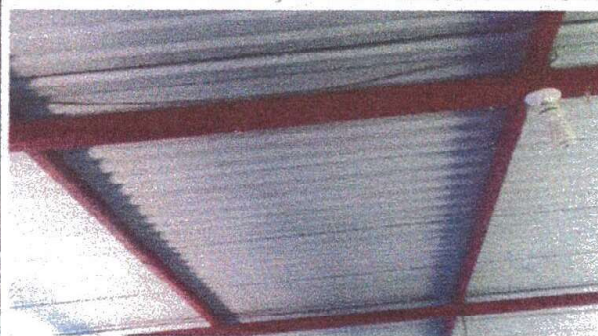
Foto 2: MODULO II, Reparación del sistema eléctrico
