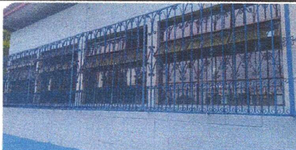
Foto 5: MODULO I, Mantenimiento a balcones de metal
