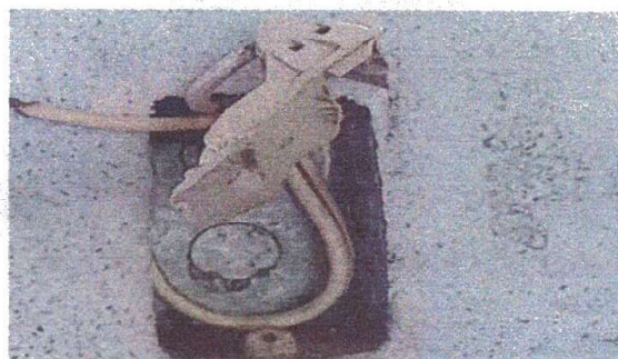
Foto 3: MODULO II, Reparación del sistema eléctrico
