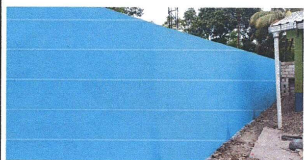
Foto 3: Sustitución de malla y block por muro perimetral
