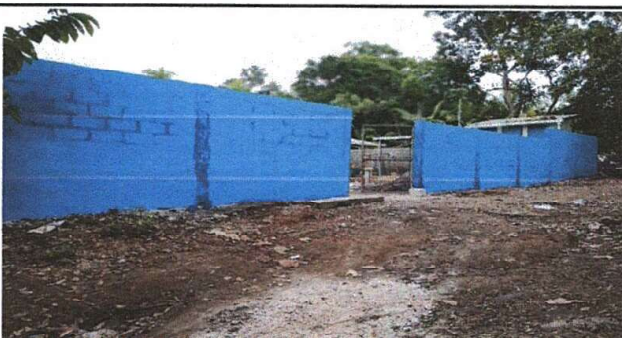
Foto 4: Sustitución de malla y block por muro perimetral
