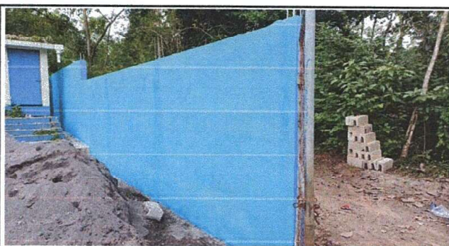
Foto 5: Sustitución de malla y block por muro perimetral
