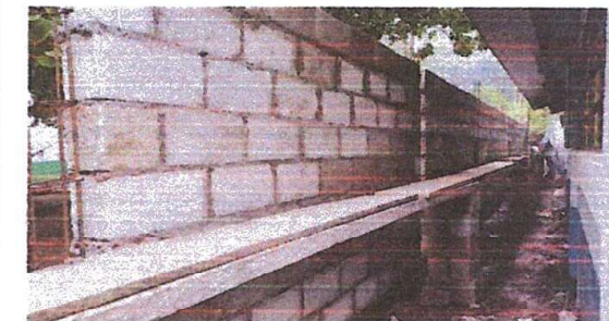
Foto 5: Sustrución de malla y block por muro perimetral
