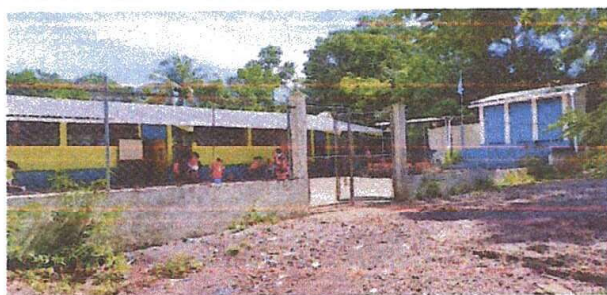
Sustitución de malla y block por muro perimetral.
