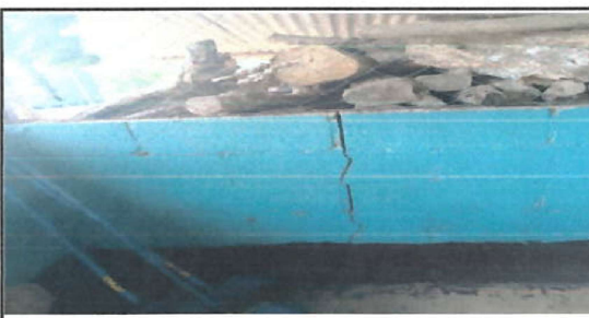
Foto 4: repello y elevacion de pared.
