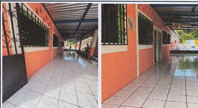
Sustitución de Torta de Cemento en mal estado, por piso Cerámico Módulo No. 1 de Aulas
