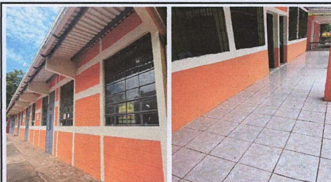
Pintura de Muros Exteriores e Interiores. Módulo No. 1 de Aulas
