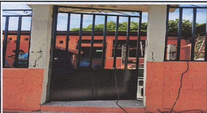
Sustitución de Puerta de Acceso de Malla Galvanizada por puerta de Metal Módulo No. 1
