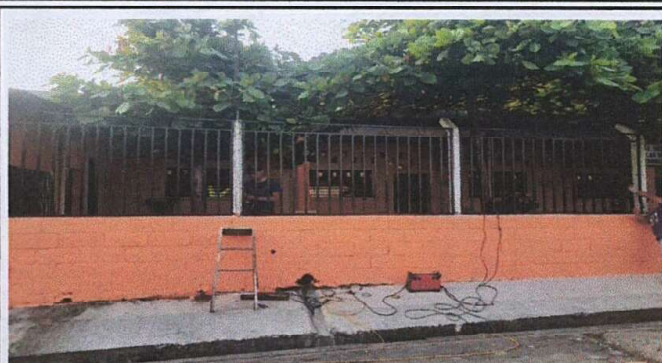
Sustitución de Malla Galvanizada por estructura de metal Módulo No. 1 Muro Perimetral
