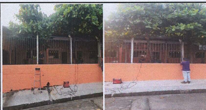
Sustitución de Malla Galvanizada por estructura de Metal. Módulo No. 2 Muro Perimetral
