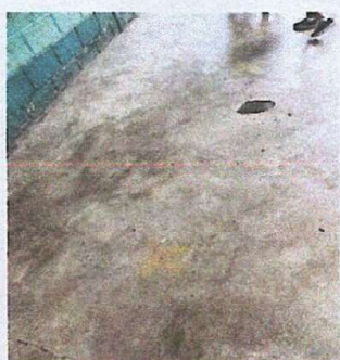
Sustitución de Torta de Cemento en mal estado, por piso Cerámico Módulo No. 1 de Aulas
