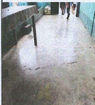
Sustitución de Torta de Cemento en mal estado, por piso Cerámico Módulo No. 1 de Aulas
