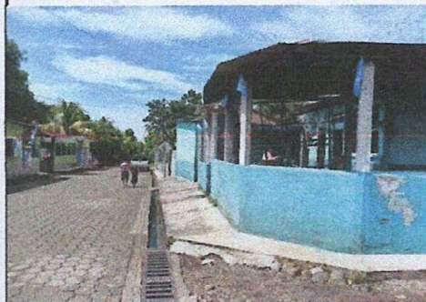
Sustitución de Malla Galvanizada por estructura de metal Módulo No. 1 Muro Perimetral
