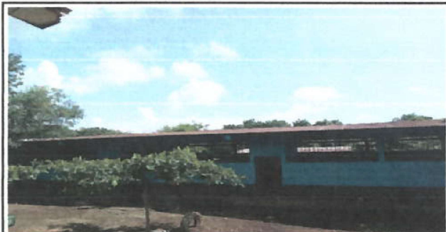
Foto 2: sustitución de techo
