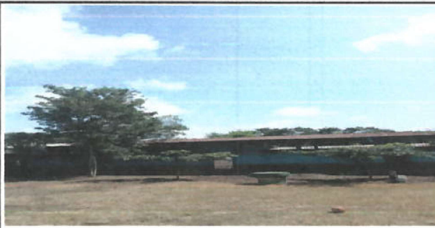
Foto 1: Repello de cemento
