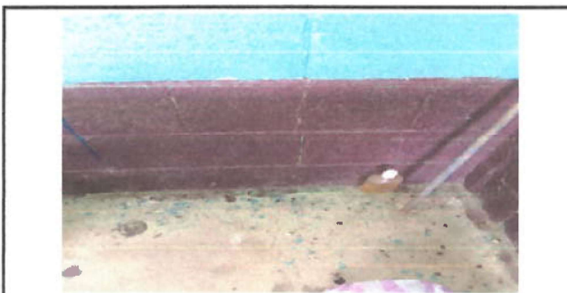
Foto 6: Reparacion de grieta con el repello
