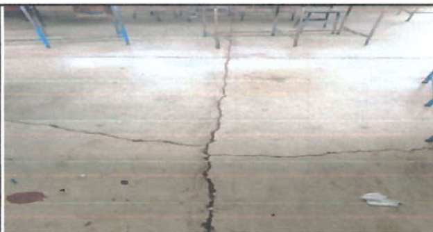
Foto 3: Remover torta reventada de cemento
