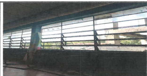
Foto 5: Balconiado de ventanas.
