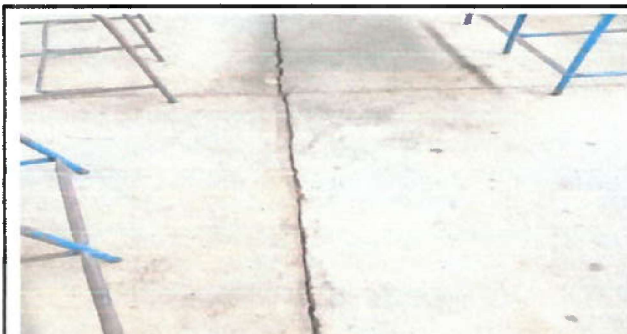
Foto 4: sustitucion de torta y colocacion de seramico.
