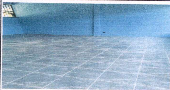
Foto1: Instalación de piso ceramico en aulas
