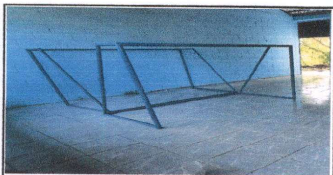
Foto 5: Instalación de piso ceramico en aulas
