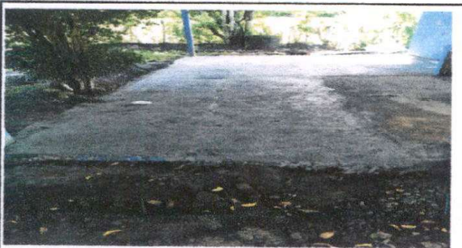
Foto 3: Suministro de losa de concreto en patio
