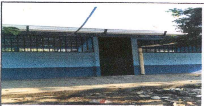
Foto 5: Sustitución de canal y bajadas de agua pluvial
