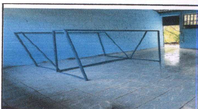
Foto 4: Instalación de piso ceramico en aulas
