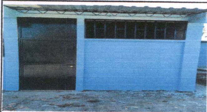
Foto1: Mantenimiento de puertas e instalación de chapas. Modulo cocina y aulas
