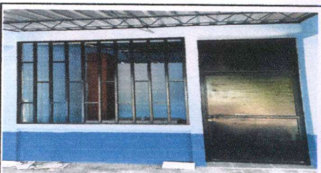
Foto 4: Sustitución de balcon de estructura metálica y mantenimiento de puerta de metal
