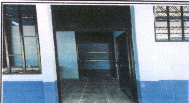
Foto 2: Reparación de área de cocina
