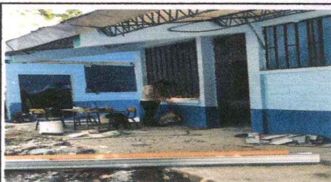
Foto 4: Sustitución de balcon de estructura metálica, mantenimiento de puerta de metal
