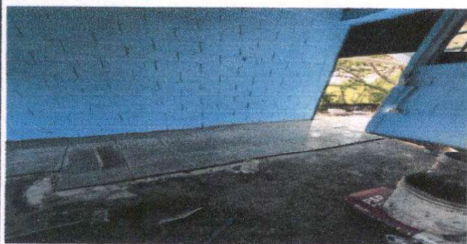
Foto 1: Instalación de piso ceramico en aulas
