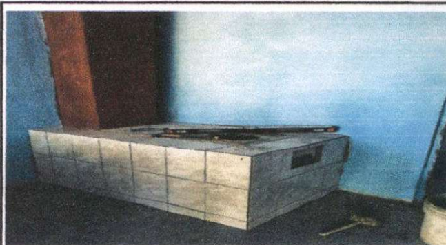
Foto 2: Reparación de área de cocina
