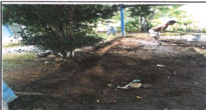
Foto 3: Suministro de losa de concreto en patio
