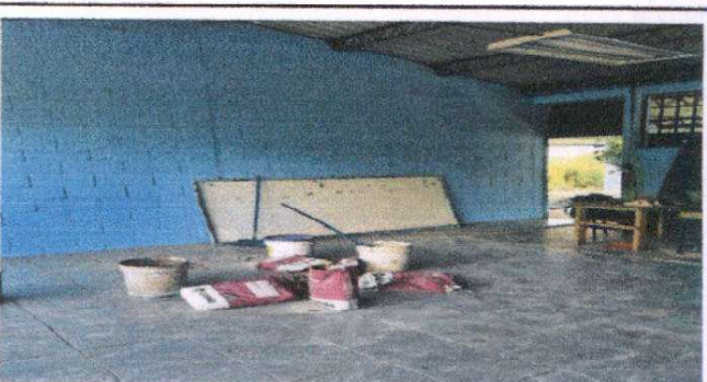
Foto 6: Instalación de piso ceramico en aulas
