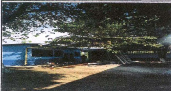
Foto 1: Mantenimiento de puertas e instalación de chapas. Modulo cocina y aulas
