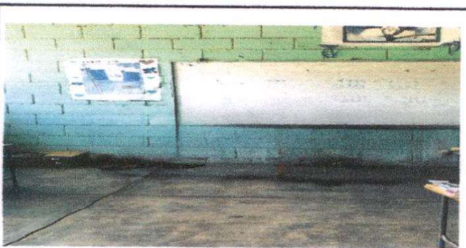
Foto 5: Instalación de piso ceramico en aulas
