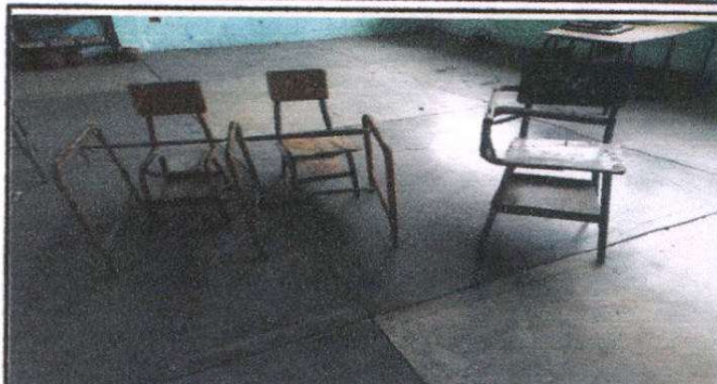
Foto 2: Instalación de piso ceramico en aulas
