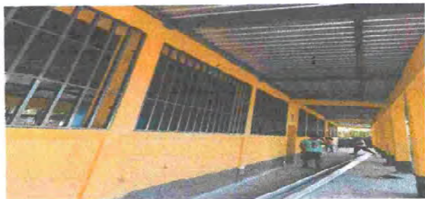
Foto 5: Sustrucción de balcones en modulo V
