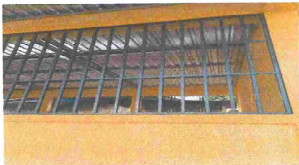
Foto 1: Sustrucción de techo en modulo de aula 1
