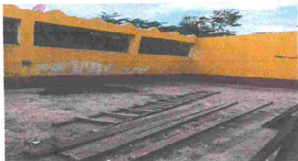
Foto 1: Sustitución de techo en modulo de aula 1
