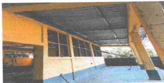
Foto 2: Sustitución de piso torta de cemento a piso cerámico en modulo de aula 2
