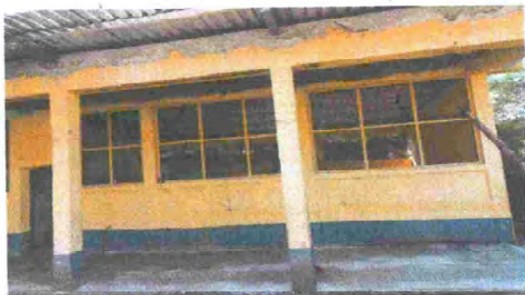
Foto 5: Sustitución de balcones en modulo V
