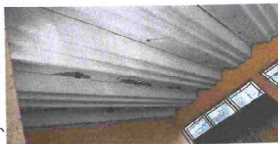
Foto 6: Sustrucción de techo en modulo II
