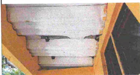
Foto 1: Sustrucción de techo en modulo de aula 1
