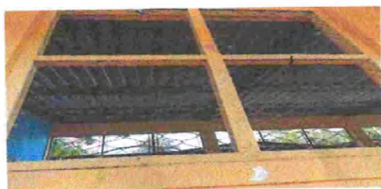
Foto 5: Sustrucción de balcones en modulo V
