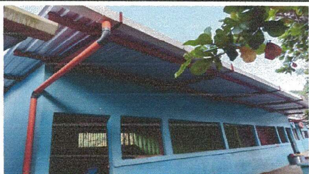
Foto 1: Sustrucción de lámina por lámina troquelada, modulo No. 1.
