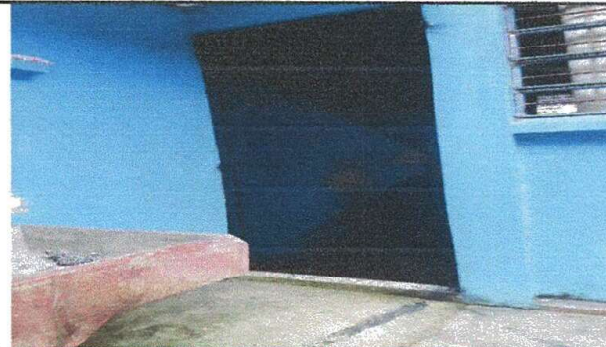
Foto 2: Mantenimiento de Puertas de aulas, modulo No. 2.
