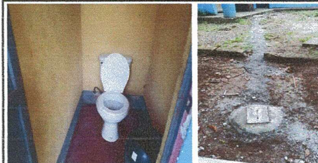
Foto 6 y 7: Sustrucción de kit de accesorios sanitarios y sustitución de tuberías de aguas negras, modulo 6 y 7.
