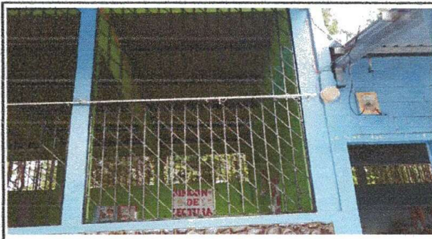
Foto 4: Mantenimiento de Balcón, modulo No. 4.
