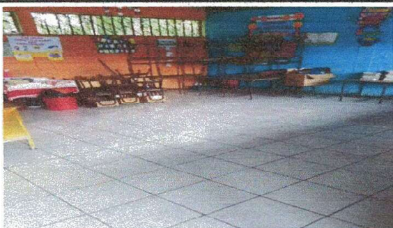
Foto 5: Sustrucción de piso granito por piso cerámico en aulas, modulo No. 5.
