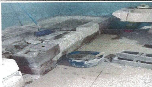
Foto 3: Sustitución de ventilación por medio de chimenea de cocina, modulo No. 3.
