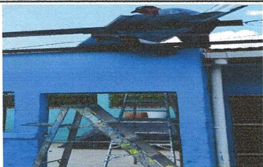
Foto 1: Sustitución de lámina por lámina troquelada, modulo No. 1.
