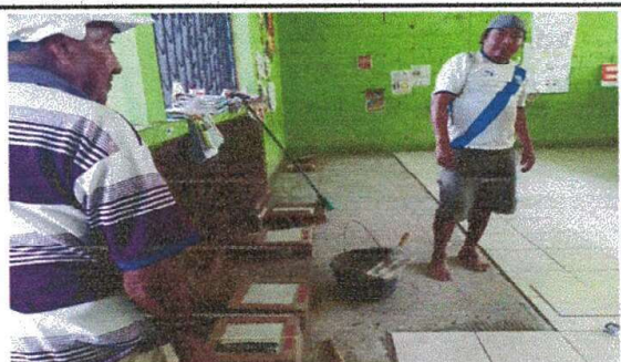
Foto 5: Sustitución de piso granito por piso cerámico en aulas, modulo No. 5.
