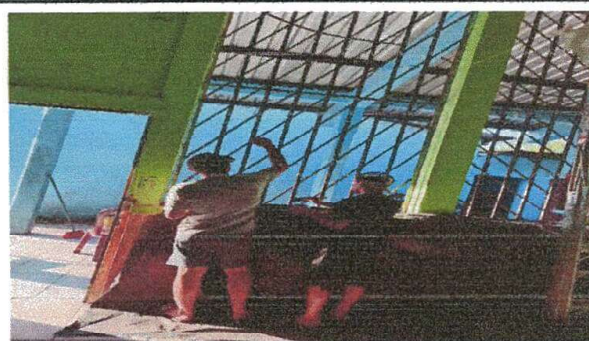
Foto 4: Mantenimiento de Balcón, modulo No. 4.
