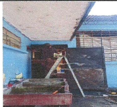
Foto 2: Mantenimiento de Puertas de aulas, modulo No. 2.
