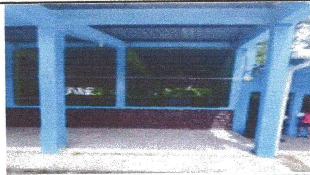
Foto 4: Mantenimiento de Balcón, modulo No. 4.
