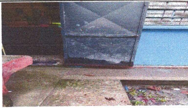
Foto 2: Mantenimiento de Puertas de aulas, modulo No. 2.
