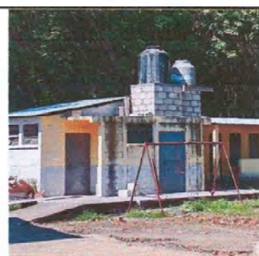
Foto 18: cambio de ubicación de depósito de agua
