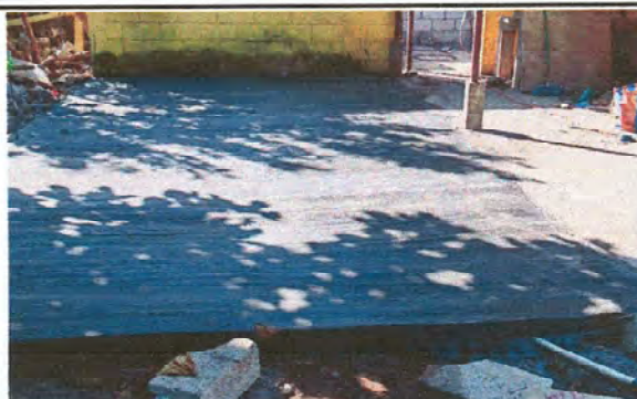
Foto 14: sustitución de piso de torta de concreto en patio
