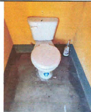
Foto 4: CAMBIO DE 6 INODOROS
