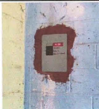
Foto 13: sustitución de tablero de flipones y sus flipones
