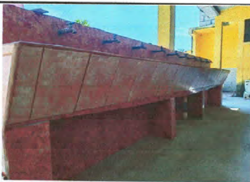
Foto 5: REPARACION DE CERAMICO EN LOS LAVAMANOS
