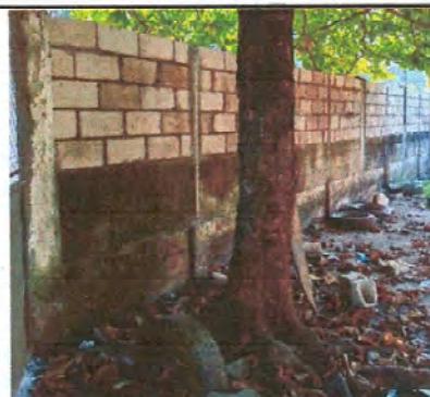
Foto 8: CAMBIO DE MALLA POR BLOCK EN PERÍMETRO DE LA CALLE EN MURO PERIMETRAL
