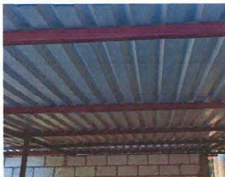
Foto 7: CAMBIO DE LAMINA Y COLUMNAS DE GALERA EN PATIO
