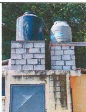
Foto 17: cambio de ubicación de depósito de agua
