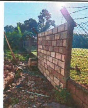
Foto 6: REPARACION Y CAMBIO DE PERÍMETRO POR BLOCK en muro perimetral
