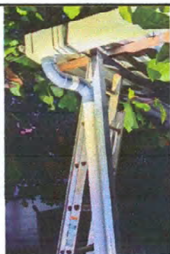
Foto 3: sustitución de canal de agua pluvial en galera
