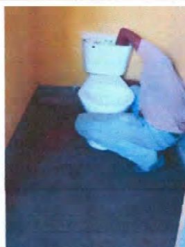
Foto 4: CAMBIO DE 6 INODOROS
