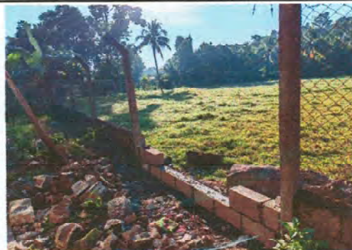
Foto 6: REPARACION Y CAMBIO DE PERIMETRO POR BLOCK en muro perimetral
