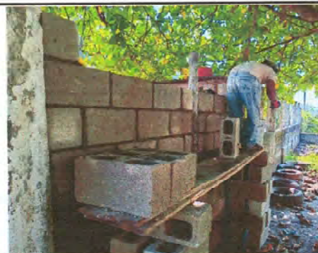
Foto 8: CAMBIO DE MALLA POR BLOCK EN PERÍMETRO DE LA CALLE EN MURO PERIMETRAL
