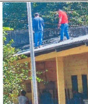
Foto 10: REPARACION DE CAPOTE Y REPARACION DE LÁMINAS DAÑADAS
