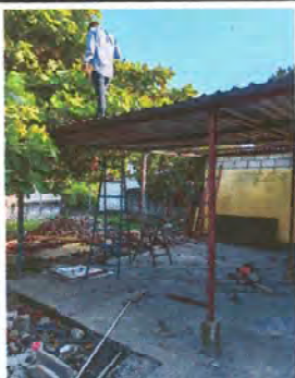
Foto 7: CAMBIO DE LAMINA Y COLUMNAS DE GALERA EN PATIO
