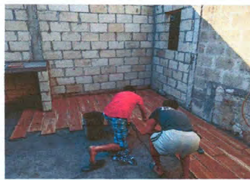
Foto 2: cambio de torta de piso por piso cerámico en cocina
