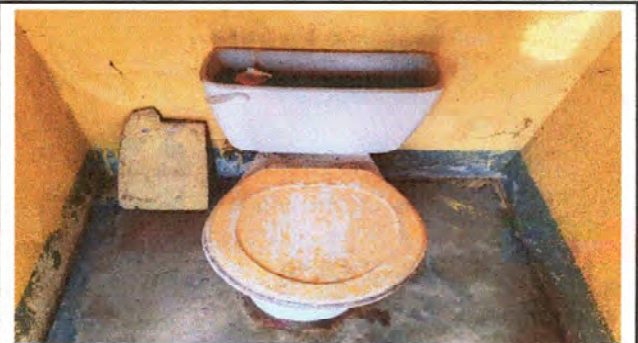
Foto 4: CAMBIO DE 6 INODOROS
