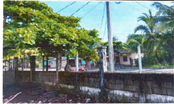
Foto 8: CAMBIO DE MALLA POR BLOCK EN PERIMETRO DE LA CALLE EN MURO PERIMETRAL
