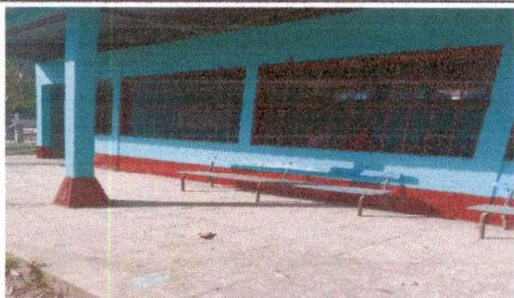
Pintura de exterior e interior en aulas.
