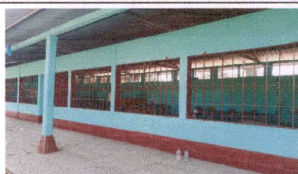
Mantenimiento de balcones en aulas.
