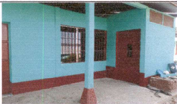
Sustitución de puerta en mal estado en bodega.
