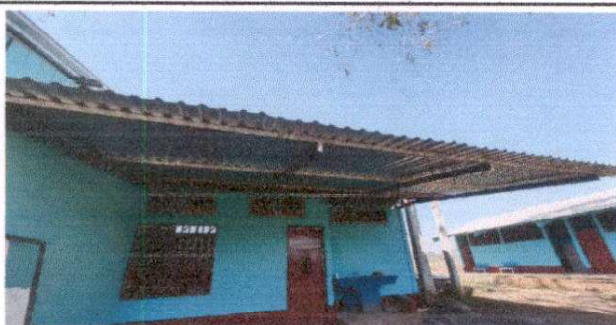
Mejoramiento de voladizo de techo cocina.
