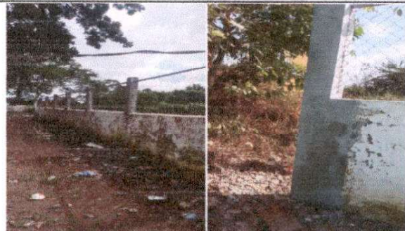
Reparación de muro perimetral.
