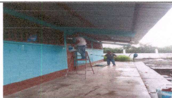
Pintura de exterior e interior en aulas.
