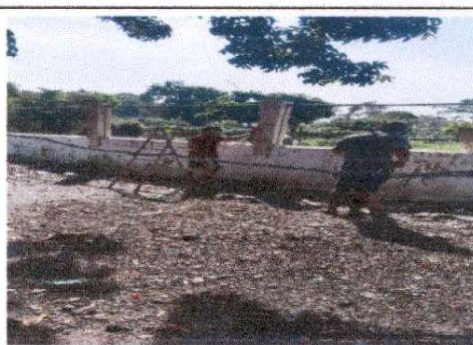
Reparación de muro perimetral.
