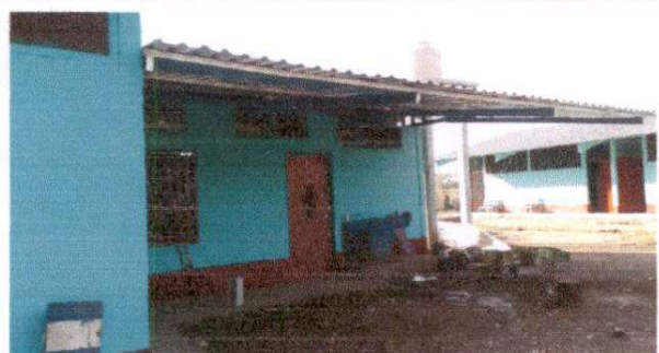
Mejoramiento de voladizo de techo cocina.
