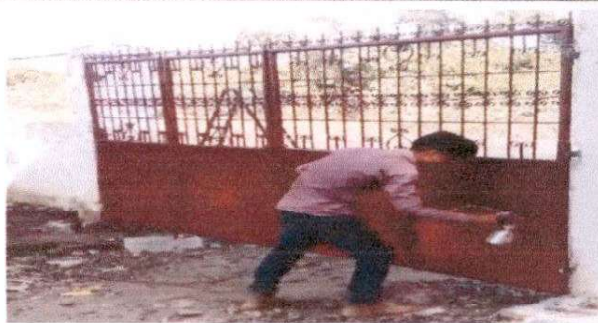
Sustitución de portón de malla en mal estado.
