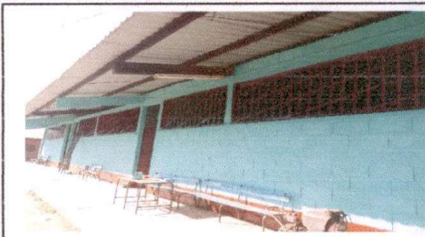
Mantenimiento de balcones en aulas.
