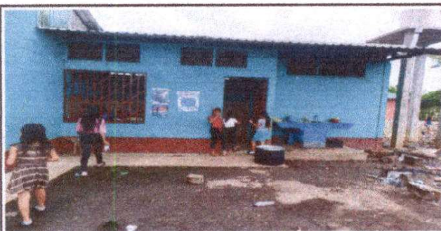
Mejoramiento de voladizo de techo cocina.
