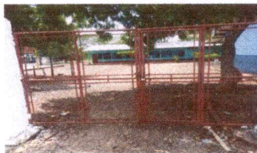
Sustitución de portón de malla en mal estado.
