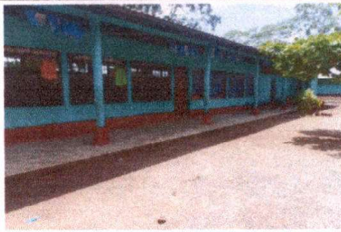
Mantenimiento de balcones en aulas.
