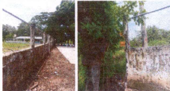
Repación de muro Perimetral.
