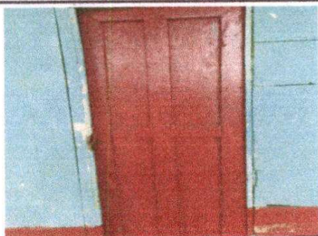
Sustitución de puerta en mal estado en bodega.
