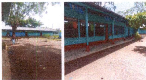
Pintura de Exterior e Interior en aulas.
