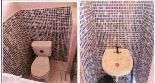
Foto 2: Sustrucción de inodoro e instalación de azulejo en servicios sanitarios
