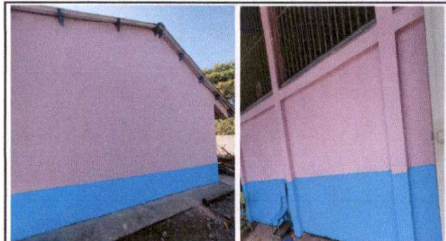
Foto 4: Pintura en paredes exteriores a dos manos,
