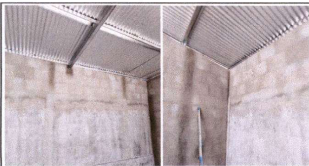
Foto 11: Ampliación de trabajos, levantamiento de tres hiladas de block en muro ya existente
