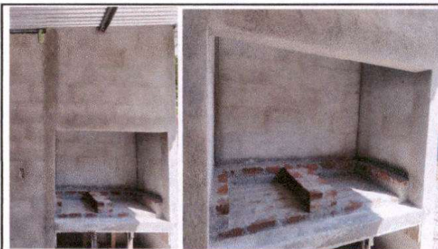
Foto 10: Sustitución de fogón por un fogón de dos espacios con chimenea de concreto
