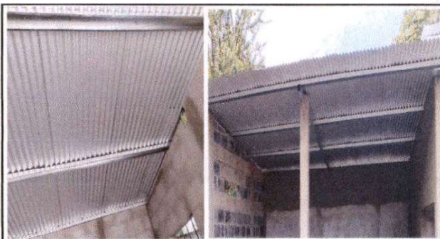
Foto 12: Ampliación de trabajos, Instalación de estructura y techo en espacio de cocina
