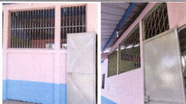
Foto 3: Mantenimiento de estructura (limpieza, lijado, y aplicación de pintura anticorrosiva) Ampliación de trabajo a mantenimiento de balcones (limpieza, lijado y aplicación de pintura anticorrosiva)
