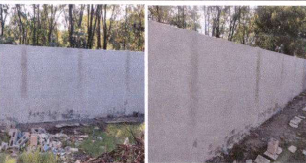
Foto 5: Muro perimetral con refuerzo de mampostería en hileras ya existentes, levantado de 07 hileras con cernido gris,
