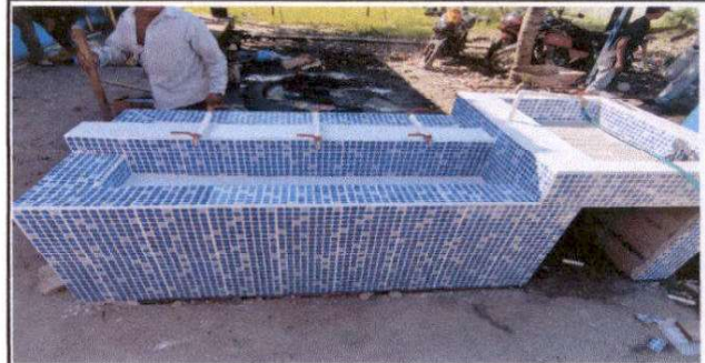
Foto 6: Sustrucción de lavamanos de porcelana a estación de lavamanos de siete chorros recubierto de azulejo
