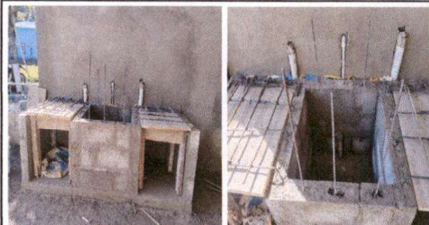
Foto 6: Sustitución de pila hecha de un lavadero por pila hecha de dos lavaderos con cubierta de azulejo y accesorios
