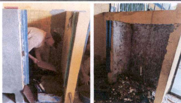
Foto 2: Sustitución de inodoro e instalación de azulejo en servicios sanitarios
