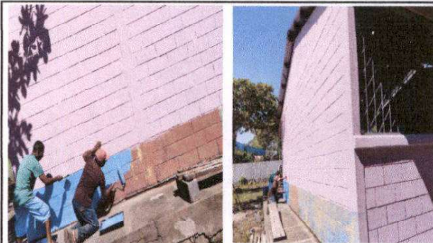
Foto 4: Pintura en paredes exteriores a dos manos, sustitución de fosa séptica por daños irreparables
