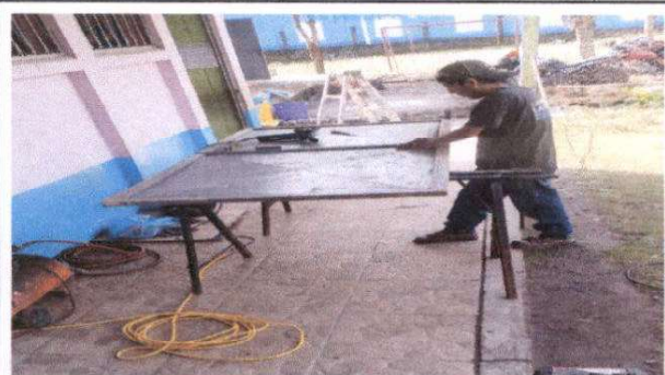
Foto 3: Mantenimiento de estructura (limpieza, lijado, y aplicación de pintura anticorrosiva)
