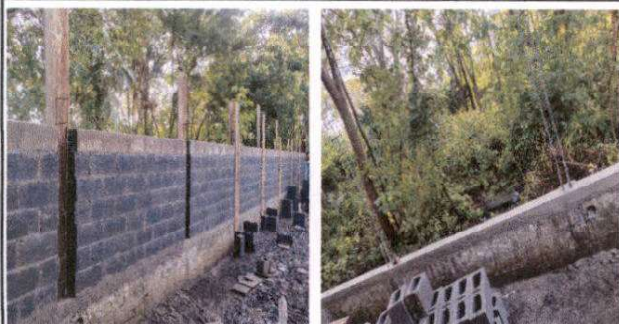
Foto 5: Muro perimetral con refuerzo de mampostería en hieleras ya existentes, levantado de 07 hileras con cernido gris, repello en muro perimetral
