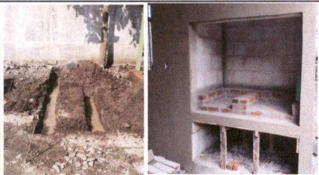
Foto 1: Levantamiento de Fogón de dos espacios con chimenea de concreto
