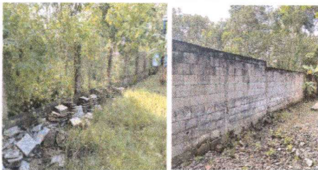
Foto 5: Muro perimetral con refuerzo de mampostería en hieleras ya existentes, levantado de 07 hileras con cemento gris, repello en muro perimetral
