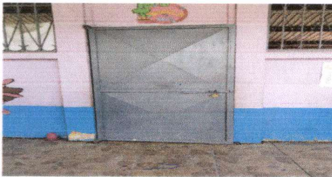
Foto 3: Mantenimiento de estructura (limpieza, lijado, y aplicación de pintura anticorrosiva)
