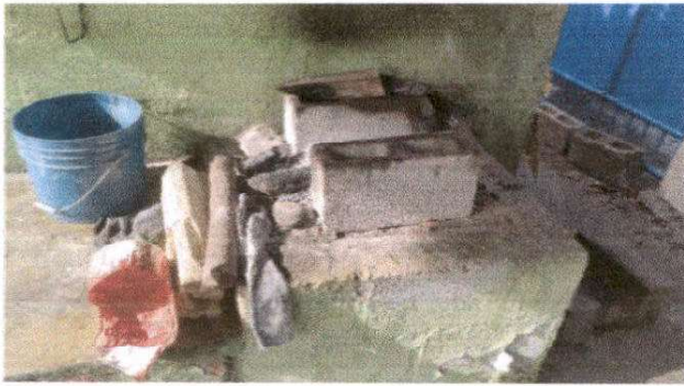
Foto 1: Levantamiento de Fogón de dos espacios con chimenea de concreto
