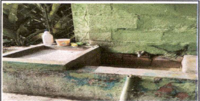
Foto 6: Sustitución de pila hechiza de un lavadero por pila hechiza de dos lavaderos con cubierta de azulejo y accesorios
