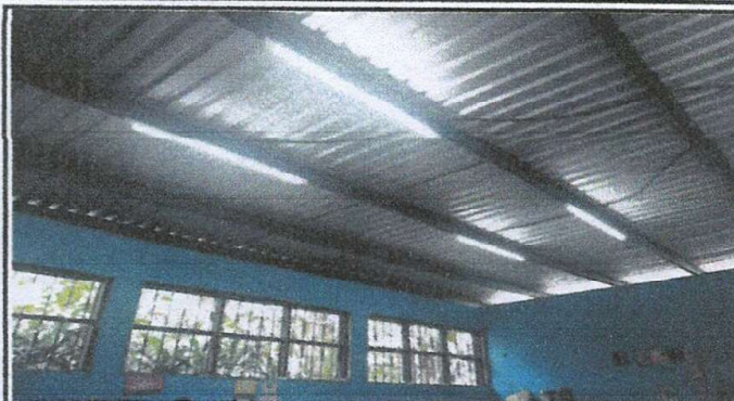
Foto 2: Instalación de 4 lámparas led y tomas corriente en 3 aulas y cambio de cableado
