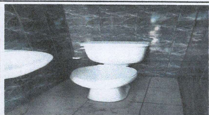
Foto 3: Instalación completa de servicio sanitario y lavamanos
