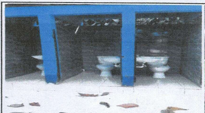
Foto 4: Instalación de azulejo y piso cerámico en los baños
