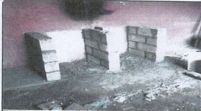
Foto 1: construcción del gabinete de 0.60x 3.00 mts
