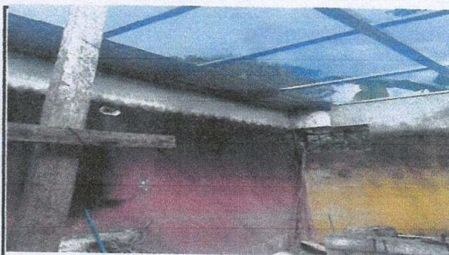
Foto 4: Enlaminado de la cocina con sus vigas respectivas
