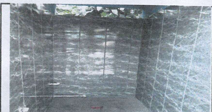
Foto 5: azulejado de baños y aplanado de piso para la aplicación del piso
