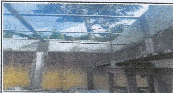
Foto 3: construcción de tres muros de concreto para reforzar las paredes de la cocina, ya que no contaban con la misma
