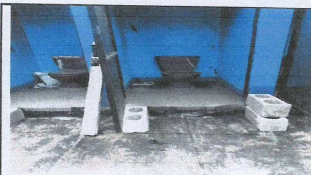
Foto 6: nivelación del piso de los baños para luego instalación de piso, tanto adentro como afuera
