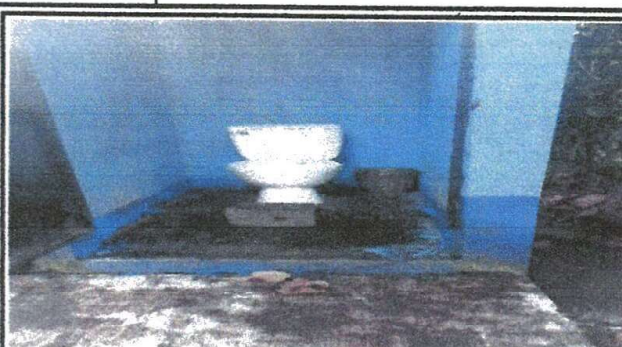
Foto 2: sustitución de inodoros, sustitución de piso y suministro de azulejo en servicios sanitarios
