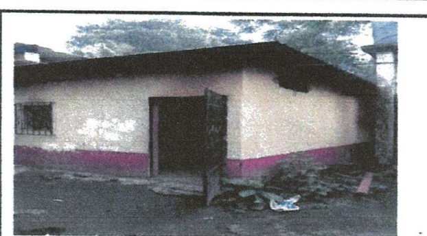
Foto 6: Reparación de área de cocina
