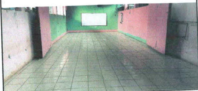
Foto 4: Sustitución de piso cerámico
