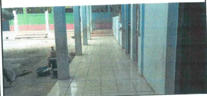
Foto 1: Sustitución de piso cerámico en el corredor
