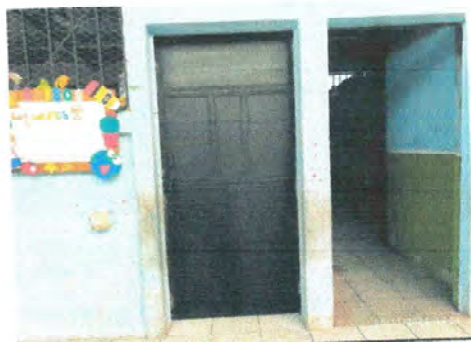
Foto 2: Sustitución de puerta de metal de 0.9 x 2.10 metros
