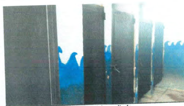
Foto 6: Sustitución de puerta de servicio sanitario.
