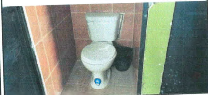
Foto 3: Instalación de baño y accesorios
