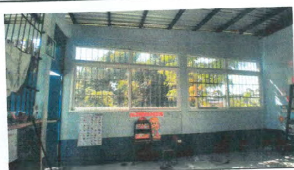
Foto 5: Instalación de ventana PVC
