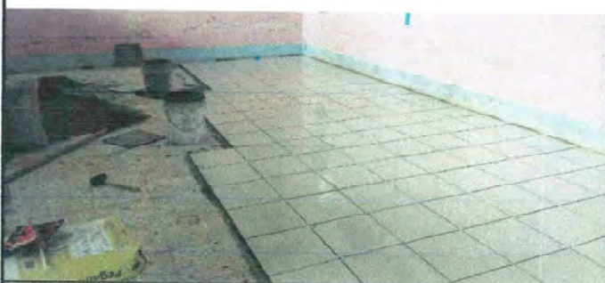
Colocación de piso cerámico.
