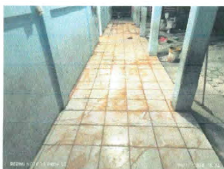
Foto 2: Colocación de piso cerámico en el corredor
