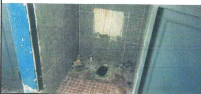
Foto 4: Sustitución de servicios sanitarios
