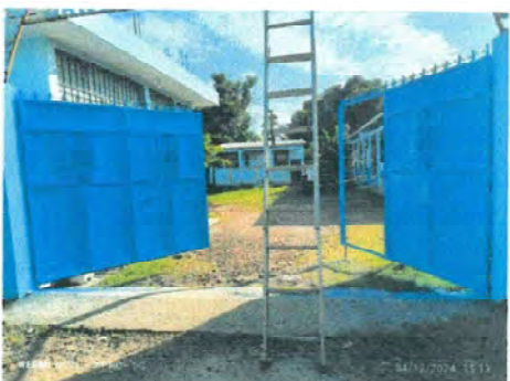
Foto 3: Mantenimiento de Portón
