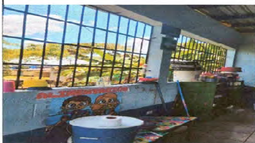
Foto 1: Instalación de ventanas de pvc
