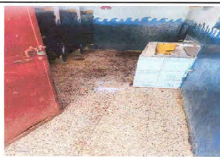
Foto 4: Sustitución de puertas
