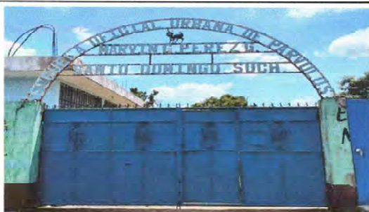
Foto 5: Reparación de porton
