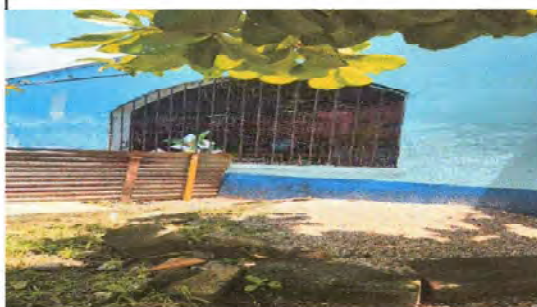
Foto 2: Instalación de ventanas de pvc
