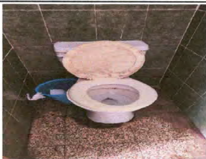
Foto 3: Sustitución de servicio sanitario y sus accesorios
