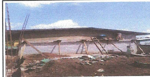
Foto 6: Sustitución de repello en muros, aula 1 y 2
