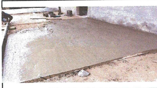
Foto 4: Reparación de plancha de concreto de patio.
