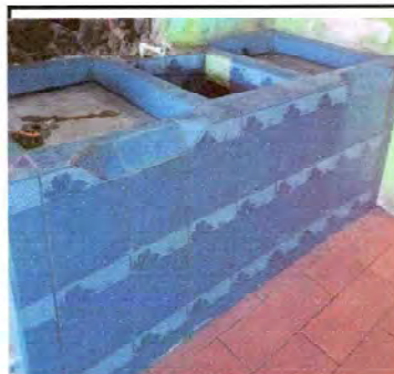
Foto 12: Sustitución de azulejo en modulo de cocina
