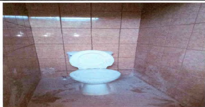
Foto 1: Sustitución de inodoros
