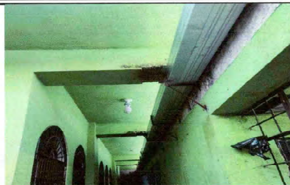
Foto 8: Sustitución de canal de metal en modulo de aula 4
