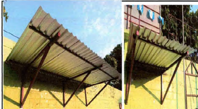
Foto 14: Sustitución de estructura, por lámina troquelada y soporte de metal, por metal en modulo de pila
