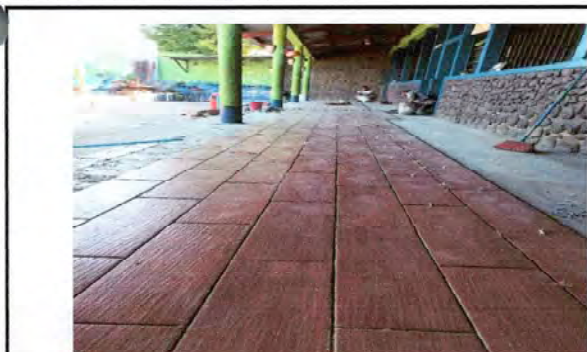
Foto 17: Sustitución de piso de granito por cerámico en modulo de 3
