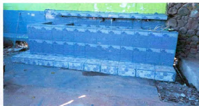
Foto 16: Sustitución de azulejos en pila en modulo de pila
