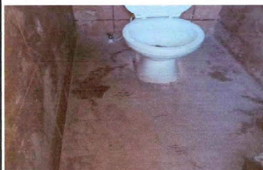
Foto 4: Sustitución de piso cerámico en modulo de servicios sanitarios
