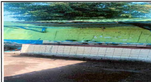
Foto 18: Repello en muro en modulo de pila
