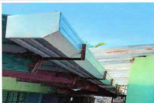
Foto 9: Sustitución de canal de metal en modulo de aula 4
