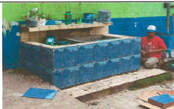
Foto 15: Sustrucción de azulejos en pila en modulo de pila
