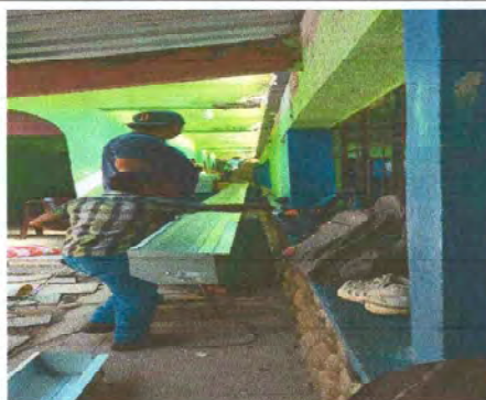
Foto 8: Sustitución de canal de metal en modulo de aula 4
