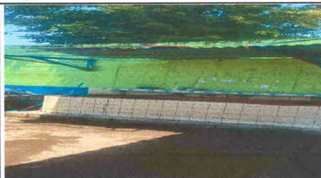
Foto 18: Repello en muro en modulo de pila
