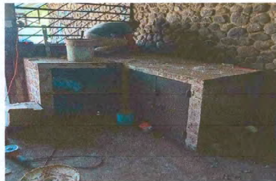
Foto 12: Sustitución de azulejo en modulo de cocina
