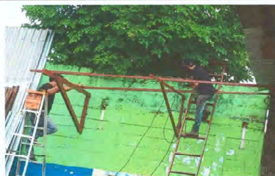
Foto 14: Sustrucción de estructura, por lámina troquelada y soporte de metal, por metal en modulo de pila
