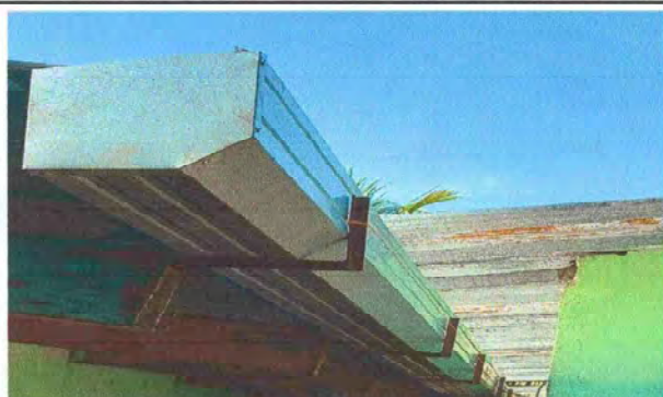
Foto 9: Sustitución de canal de metal en modulo de aula 4
