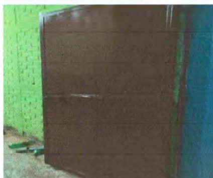
Foto 11: Sustitución de puerta de metal de modulo de cocina
