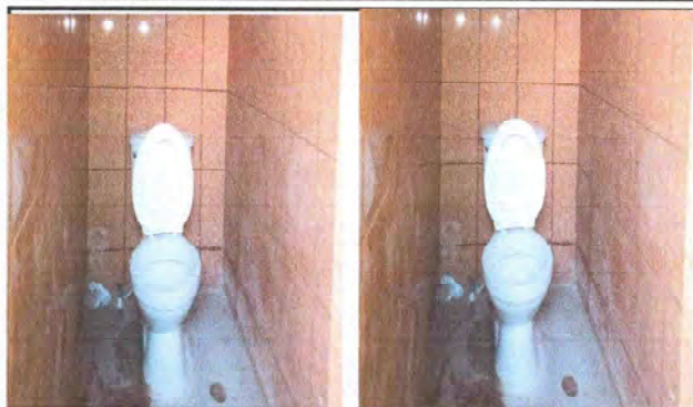
Foto 1: Sustitución de inodoros
