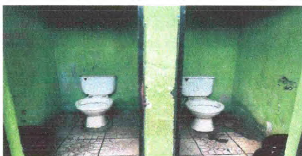
Foto 1: Sustrución de inodoros
