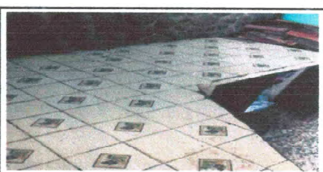
Foto 12: Sustitución de azulejo en modulo de cocina
