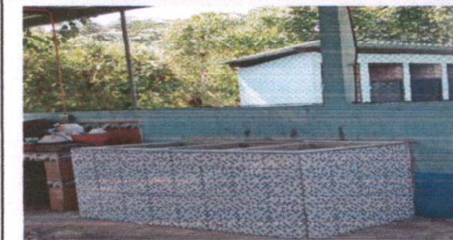
Foto 2: Sustitución de lavamanos y pilas de cemento de dos lavaderos.
