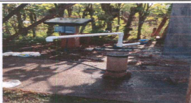
Foto 5: Sustitución de bomba de agua.
