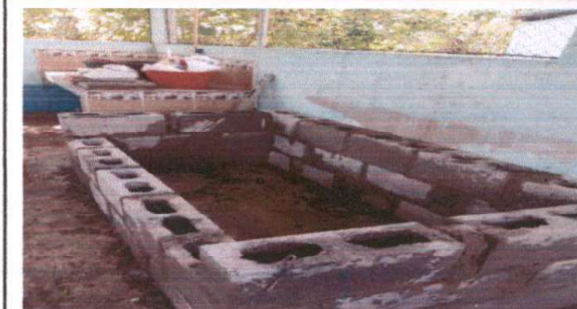
Foto 2: Sustitución de lavamanos y pilas de cemento de dos lavaderos.
