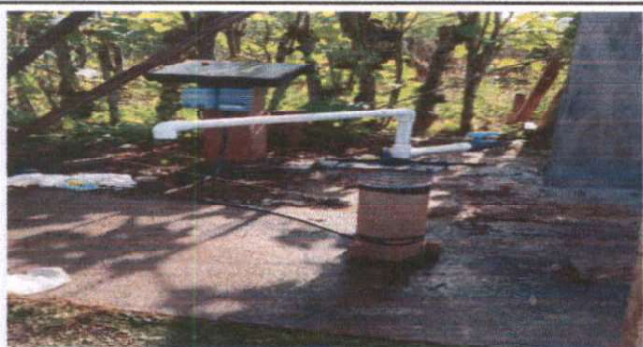
Foto 5: Sustitución de bomba de agua.
