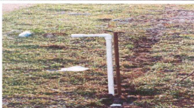
Foto 3: Sustitución de tubería línea principal, red de agua potable.
