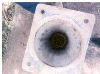
Foto 5: sustitución de bomba de agua
