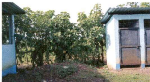
Foto1: Reparación de drenaje y Red de agua potable.
