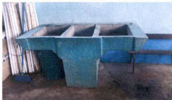
Foto 2: sustitución de lavamanos y pila de cemento de dos lavaderos.
