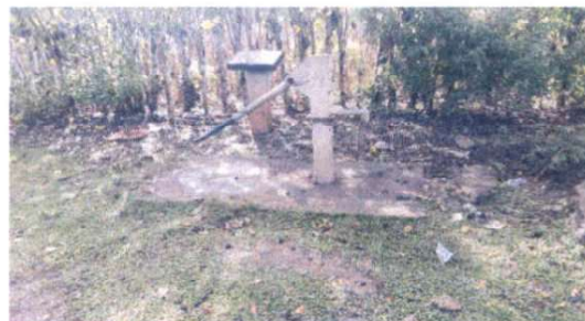
Foto 4: Reparacion y Mantenimiento de Cisternas / desposito de agua.
