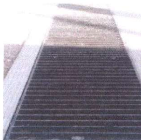
Sustitucion de cuneta de concreto por rejilla metalica
