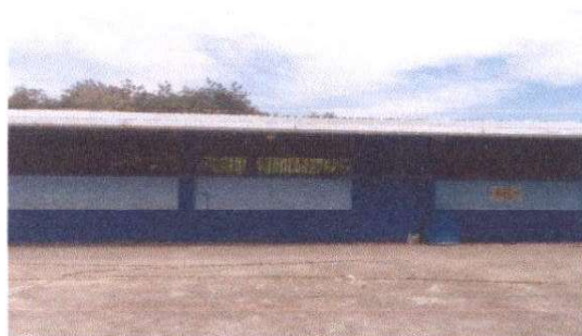
Sustitucion de canal de metal por canal de fabrica calibre 26
