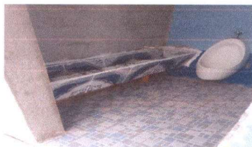
sustitución de mingitorio en baños
