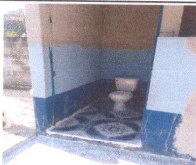
Sustitucion de piso antideslizante en sanitarios
