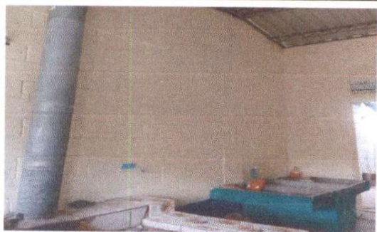
Reparación de polleton en cocina
