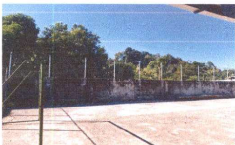
colocacion de malla en muro perimetral.
