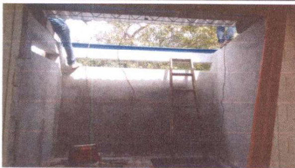
Suministro de muro de blok en cocina
