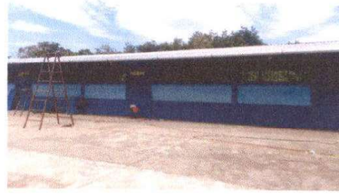
Sustitución de canal de metal por canal de fabrica calibre 26
