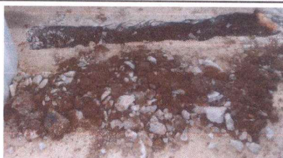
Sustitucion de cuneta de concreto por rejilla metalica.
