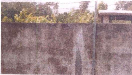
Reparación de repello en pared en muro perimetral
