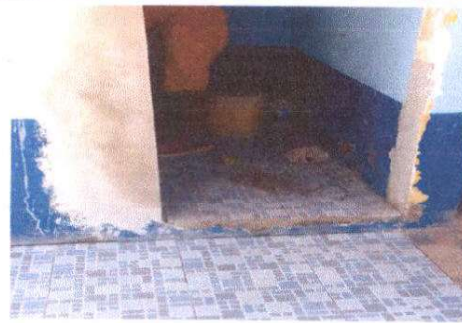
sustitución de mingitorio en baños
