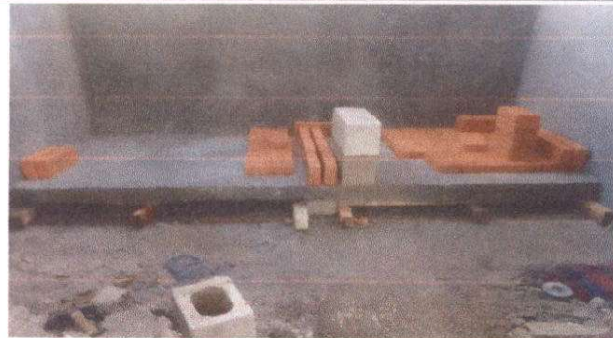
area de cocina: remodelación del polleton
