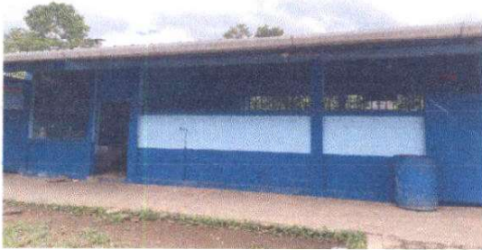
Sustitución de canal de metal por canal de fabrica calibre 26
