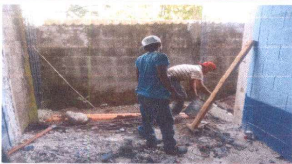
Reparacion de polleton en cocina
