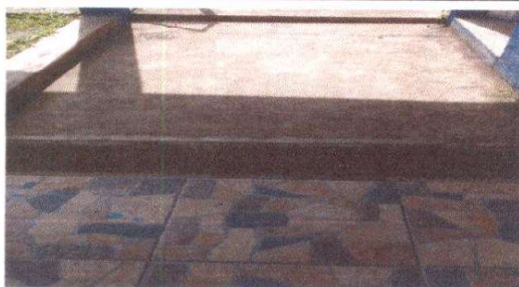
Sustitucion de piso antideslizante en sanitarios
