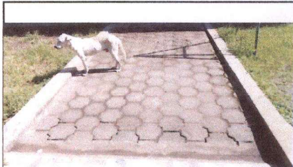
Sustitucion de cuneta de concreto
