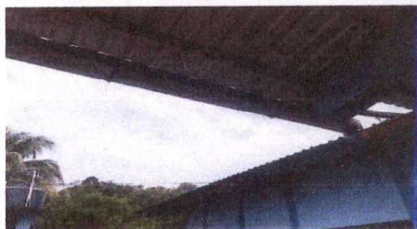
Sustitucion de canal de metal por canal de fabrica calibre 26
