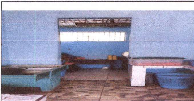
Suministro de muro de blok en cocina
