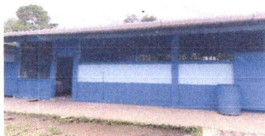
Sustitucion de canal de metal por canal de fabrica calibre 26
