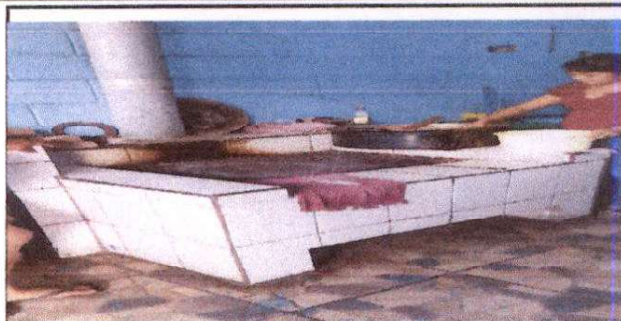
area de cocina: remodelación del polleto
