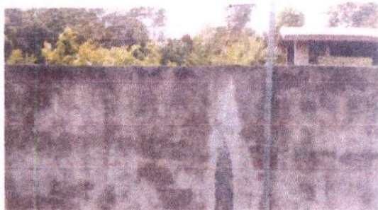
Reparacion de repello en pared en muro perimetral
