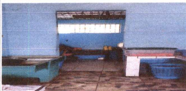
Suministro de muro de blok en cocina
