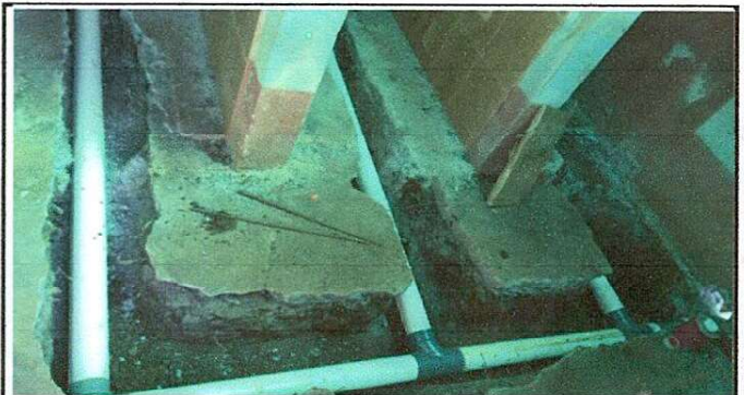
Foto 4: Reparación de red de drenaje y red de agua potable, Sustitución de tubería pvc 3 pulgada lineales de agua negra y agua principal
