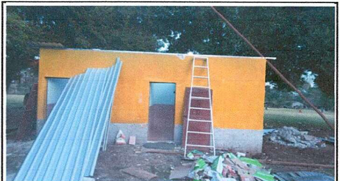
Foto 2: cubierta de lámina por lámina troquelada calibre 26 M2
