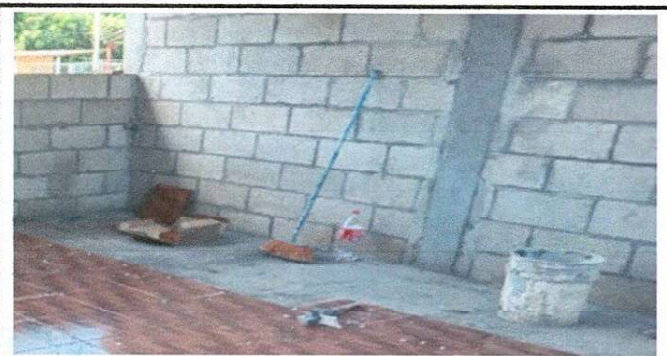
Foto 5: piso; Sustitución de piso de torta de concreto por piso cerámico
