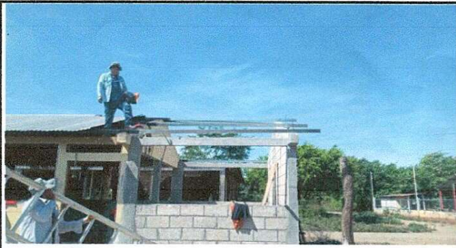
Foto 1: Estructura de techo, sustitución de estructura de soporte de metal, por metal
