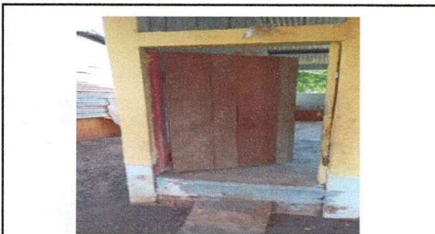
Foto 3: Sustitución de puertas 2.20 X 1 metros
