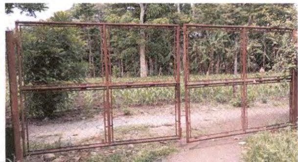
Sustitución de portón
