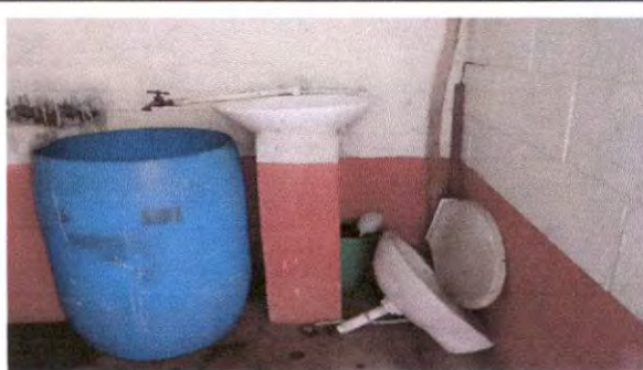
Sustitución de lavamanos
