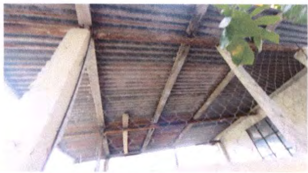
Sustitución de cubierta de láminas
