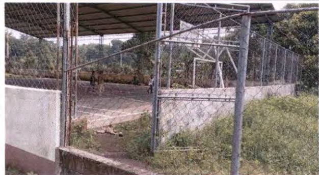
Reparación de maya que circula la escuela
