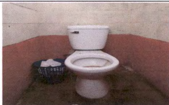
Sustitución de sanitario y sus accesorios
