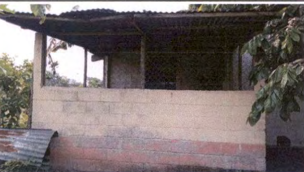
Sustitución de maya por balcones
