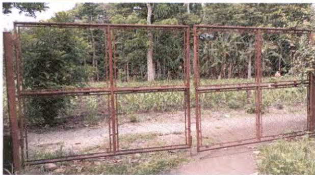
Sustitución de portón
