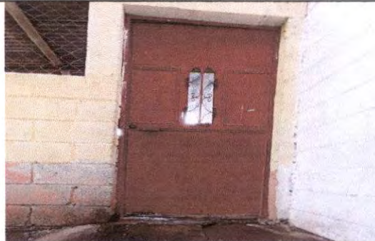
Reparación de puerta principal a cocina
