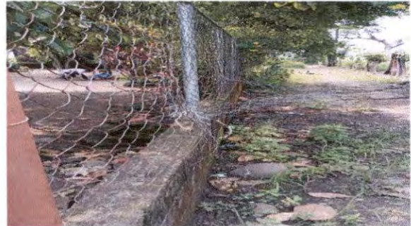
Reparación de muro perimetral con maya galvanizada, intermedios y columnas
