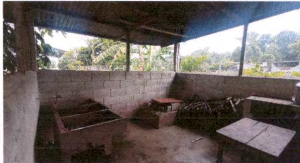
Construcción de poyetón
