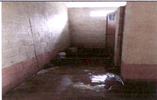
Reparación de baños
