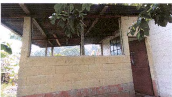
Reparación de cocina
