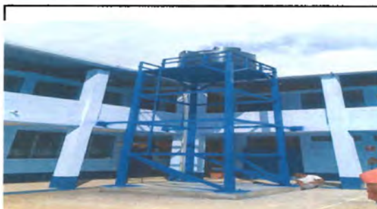
Foto 6: Trabajos terminados: fosa de concreto 4,500 litros, instalación de bomba sumergible, instalación de tubería de abasto
