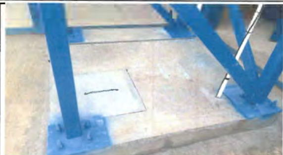
Foto 1: Inicio de instalación de estructura de metal (torre)
