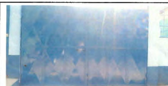
PINTURA A PORTUN Y PUERTA PRINCIPAL
