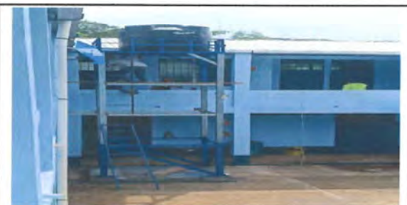
Foto 3: Instalando una escalera para poder realizar el respectivo mantenimiento
