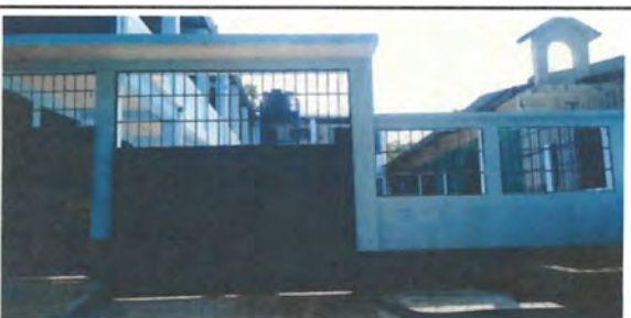
Pintura en muros exteriores e interiores 1260 ML
