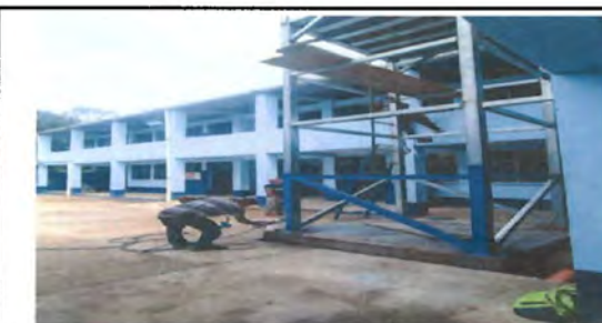
Foto 5: iniciando proceso de pintado con pintura azul anticorrosiva secado rápido
