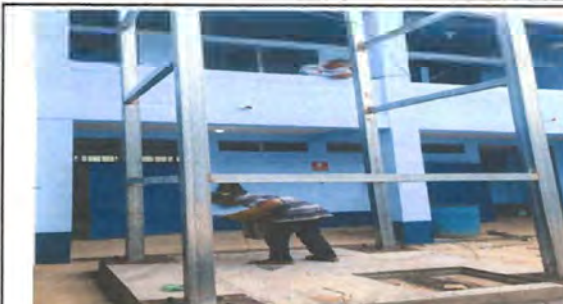
Foto 2: Fijando pernos con sus respectivas roldanas y washas de presión
