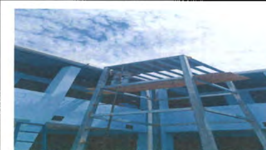
Foto 3: Instalando una escalera para poder realizar el respectivo mantenimiento
