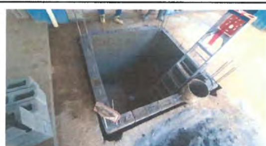
Foto 4: REPELLO PAREDES INTERNAS Y EXTERNAS
