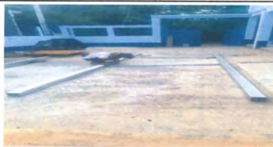
Foto 5: INICIO DE ESTRUCTURA DE MATAL
