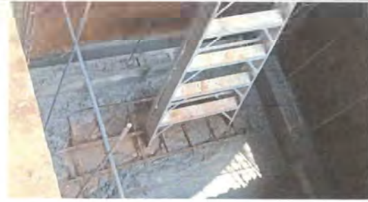
Foto 2: ENPARRILLADO Y FUNDICION DE PISO
