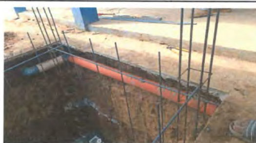
Foto 3: ARMADO DE HIERRO DE 1/2 CORRUGADO PINEADO Y SUS 4 COLUMNAS
