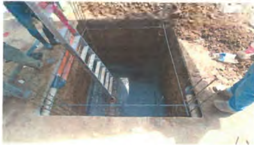
Foto 1: INICIO DE COSTRUION DE FOSA
