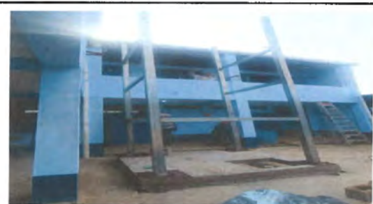
Foto 6: 4 BASES DE TUBO CUADRADO DE 4"X 4" GALVANIZADO CHAPA 14
